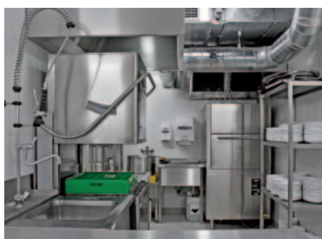
RRC Hluboká nad Vltavou
